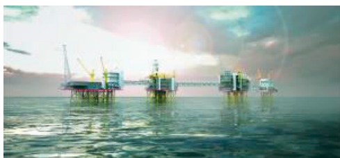
Установка Mariner в Северном море (Equinor)
